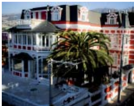
Le Palacio Astoreca aura nécessité deux ans et demi de travaux de rénovation.
