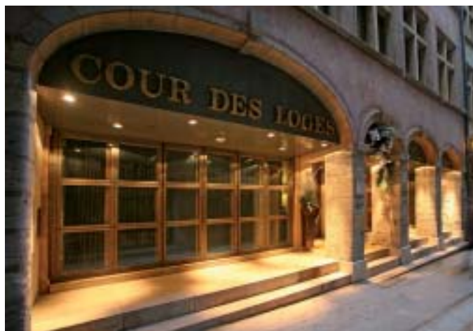
Les Loges, à la Cour des Loges.
