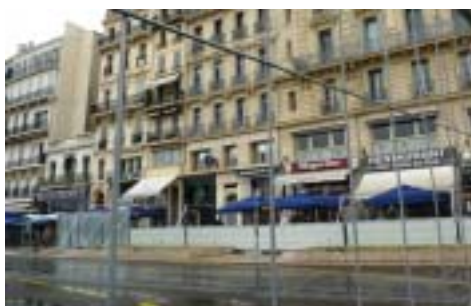
Le Vieux-Port en travaux, les professionnels sont inquiets pour la saison.
