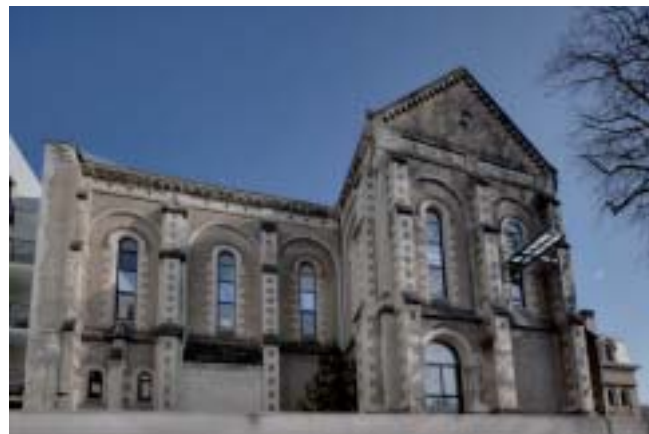
La chapelle des sœurs de Notre-Dame, vue de l'extérieur.
