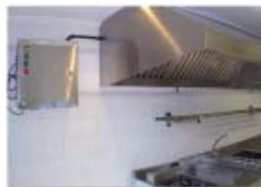
DSO 2002 est un destructeur d'odeurs de cuisine permettant de répondre efficacement aux soucis d'hygiène des établissements. Ce procédé original et novateur permet un traitement à la source par micronisation
