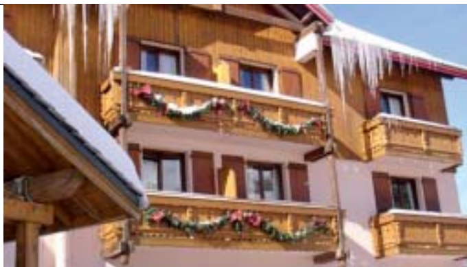
Le Ménuire, à l'entrée de la station des Ménuires, charmant chalet-hôtel 3 étoiles.
