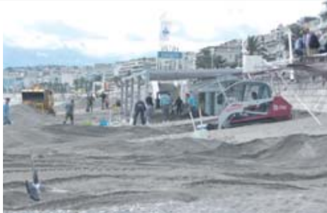
Il a fallu employer les grands moyens et recourir aux machines pour dégager les tonnes de sable accumulées, comme ici à l'Hi Beach.
