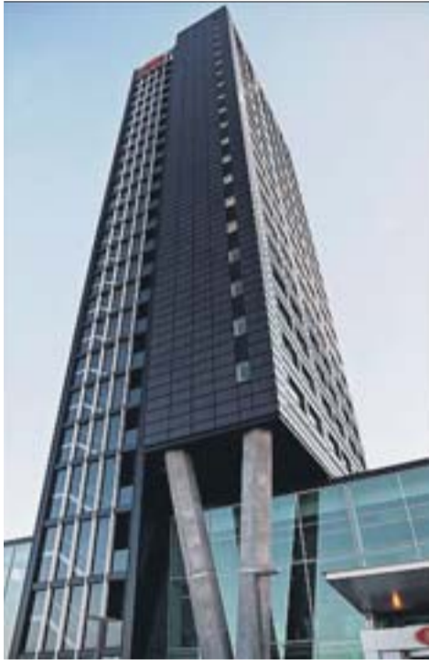
La façade de l'hôtel est recouverte de 1 500 panneaux solaires qui permettent de produire l'équivalent des besoins en énergie de 55 familles danoises.
